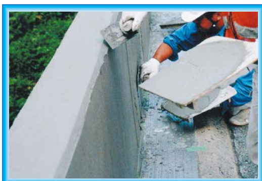
高速道路高欄補修
