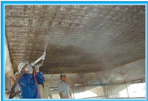
天井部吹付け施工
