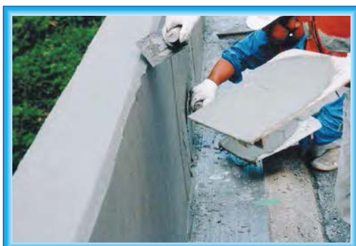
高速道路高欄補修
