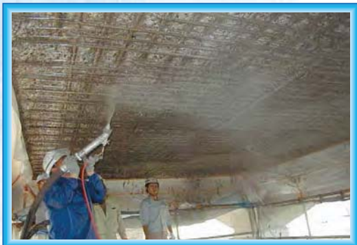
天井部吹付け施工
